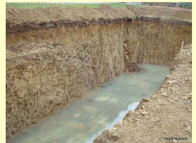
Ce trou est destiné à recevoir la réserve d'incendie (cuve de 120m3 ou 120000 litres)
